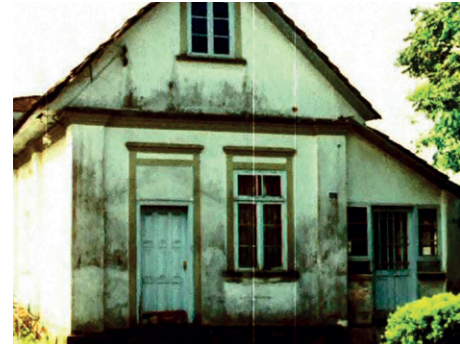
Sede da Copapel na rua Timbó. (Joinville, 1976)
